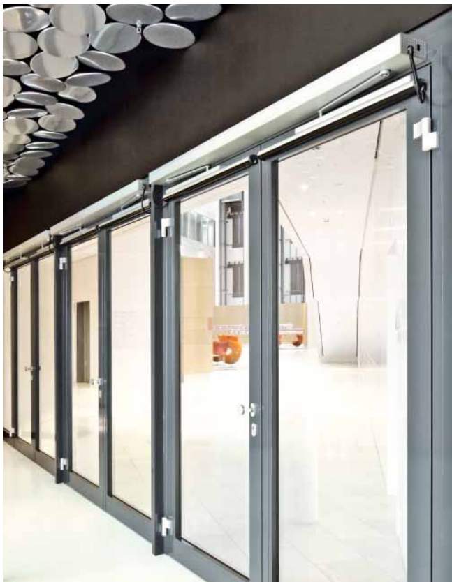
Barrierefreier Zutritt im Eingangsbereich des Hauptsitzes der Spiegel Medien-gruppe in Hamburg – mit vollautomatischen ED 100/250 Drehflügeltürantrieben.
